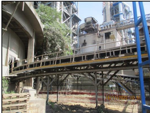
ภาพที่ 2.50 สายพานลำเลียง Biomass เข้าสู่หม้อเผาเป็นแบบปิด
