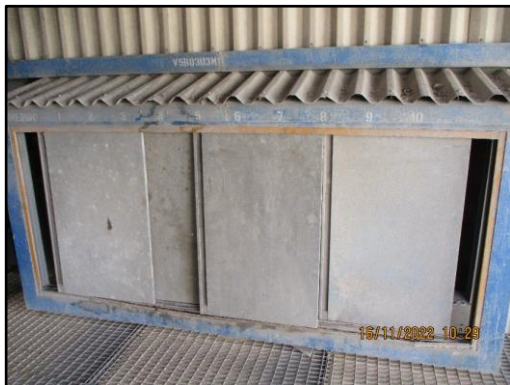
ภาพที่ 2.25 Casing หุ้มชุด Hammering Equipment ในหม้อไอน้ำ
