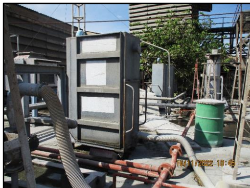
ภาพที่ 2.10 ระบบ Activated carbon
