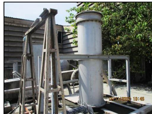
ภาพที่ 2.10 ระบบ Activated carbon
